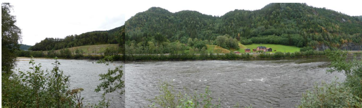
Figur 12 Bilde av Rostad og planlagt påhuggsområde og utgraving til fjell. Bebyggelsen til høyre i bildet må erverves.
